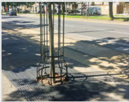
Abbildung 11 | Baumscheiben mit großem durchwurzelbarem Retentionsraum
