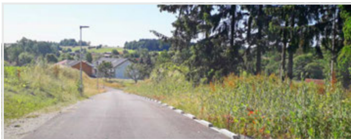
Abbildung 10 | Lineare Retentions- und Versickerungsmaßnahme durch abwechselndes Hoch- und Tiefbord
