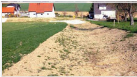
Abbildung 19 | Breit angelegte Mulde für eine kontrollierte Ableitung
