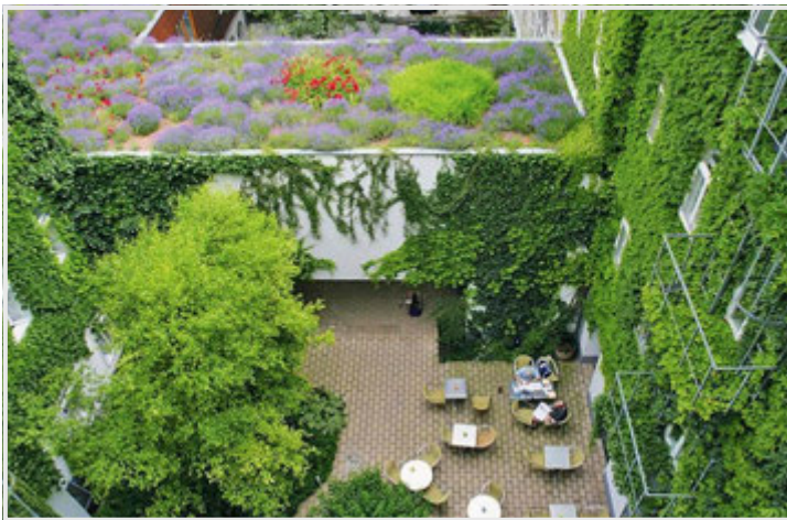
Abbildung 18 | Ansicht Fassadenbegrünung und Gründach
