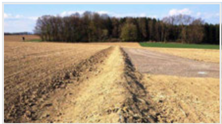
Abbildung 20 | Kleiner Erddamm zur gezielten Umleitung von Hangwässern
