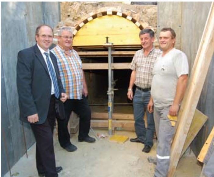
Bürgermeister Dr. Alfred Pohl, Gemeinderat Josef Strobl, Vizebürgermeister Ernst Waberer und Polier Manfred Mareiner bei der Besichtigung der Baustelle Kirchenberg
