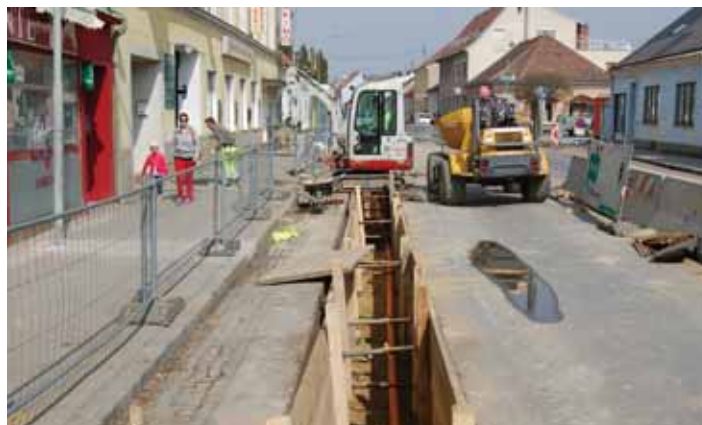
Noch bis Juni dauern die Arbeiten in der Oberhoferstraße
