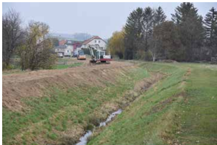
Dammsanierungsmaßnahmen am Eibesbach in Eibesthal
