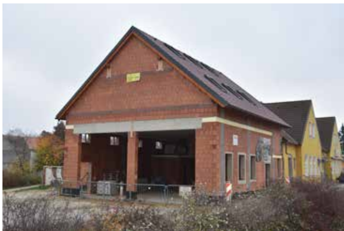
Bau des FF-Hauses in Siebenhirten
