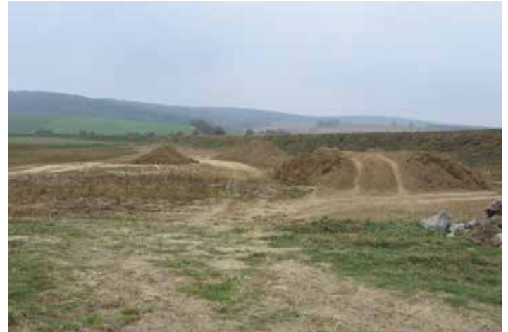
Bau eines Retentionsbeckens in Hüttendorf
