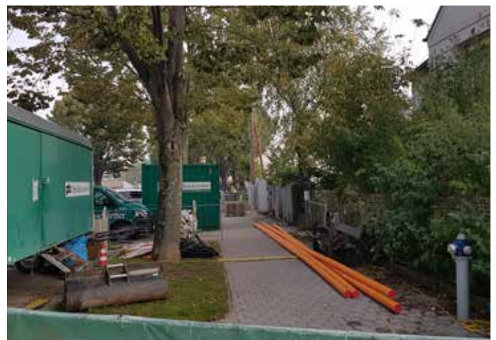
Arbeiten am Mistelsteig
