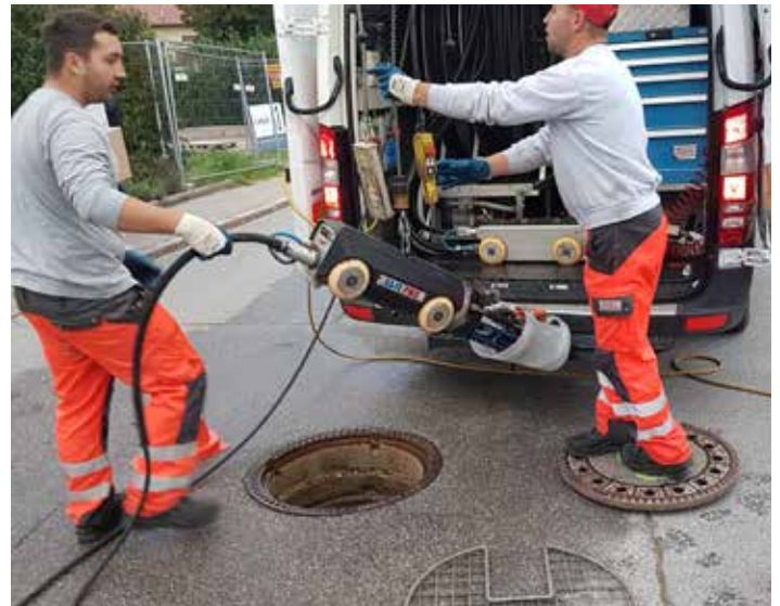
Kanalroboter in der Pater Helde-Straße
