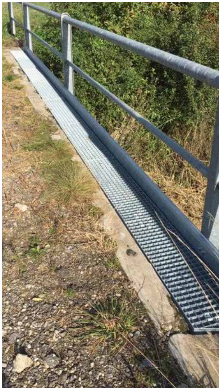
Bei der Brücke über den Eibesbach, die sich direkt neben dem Radweg befindet, hat die StadtGemeinde Mistelbach beiderseits neue Absturzsicherungen in Form einer Stahlkonstruktion mit Gitterrosten angebracht. Bauausführende Firma war die Firma „Die Metallwerkstatt GmbH“ von Ing. Hannes Wiesinger aus Hüttendorf.
