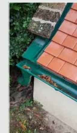
Wenn dann das Thermometer noch unter null Grad fällt, gefriert das Regen- bzw. Schmelzwasser und das Fallrohr kann platzen und ist somit ruiniert.
