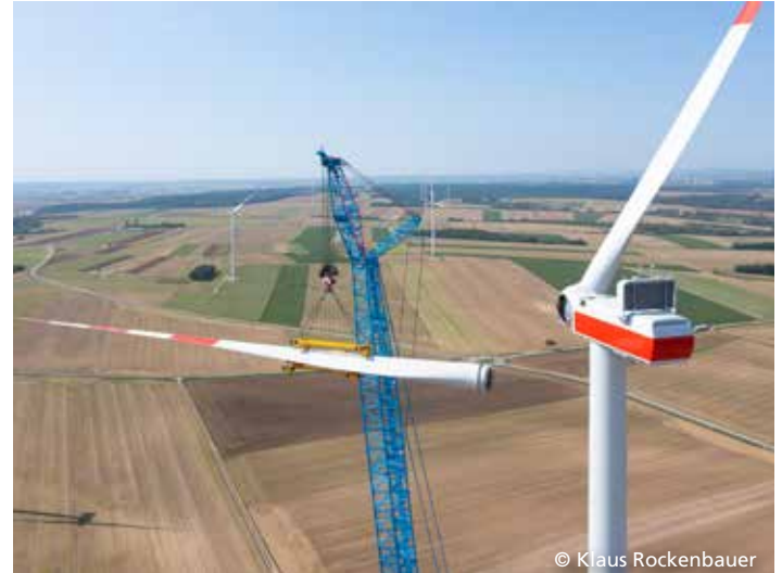
Ein Rotorblatt wird montiert
