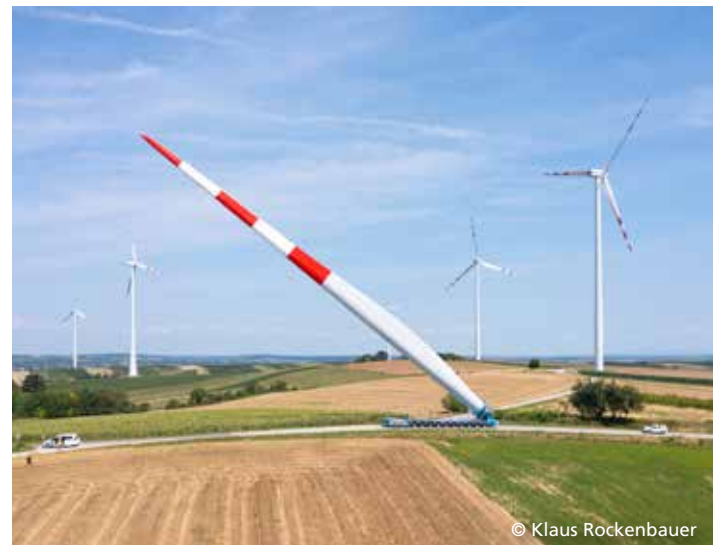
Ein Rotorblatt wird angeliefert
