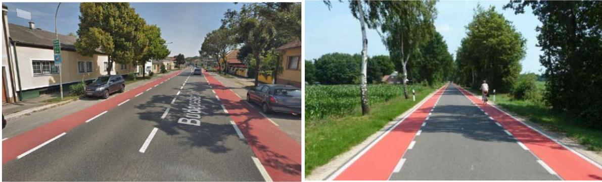
Abbildung 50: Eingefärbte Mehrzweckstreifen (links) bzw. Schutzstreifen für den Radverkehr (rechts) <sup>67</sup>
