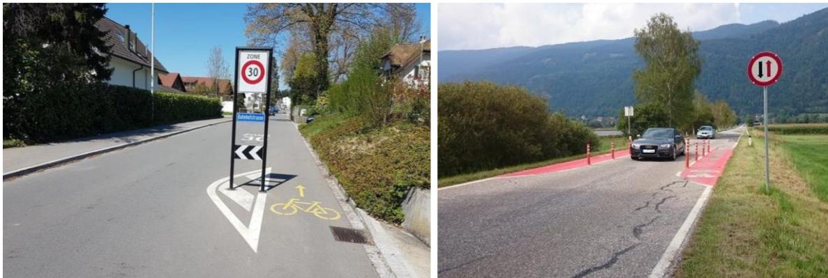
Abbildung 40: Einengung überdimensionierter Fahrbahnen mit geringem Aufwand und ohne Einschränkung der Linienführung der Radfahrer:innen (links) <sup>51</sup> / Engstelle auf einer Kärntner Landesstraße (rechts) <sup>52</sup>
