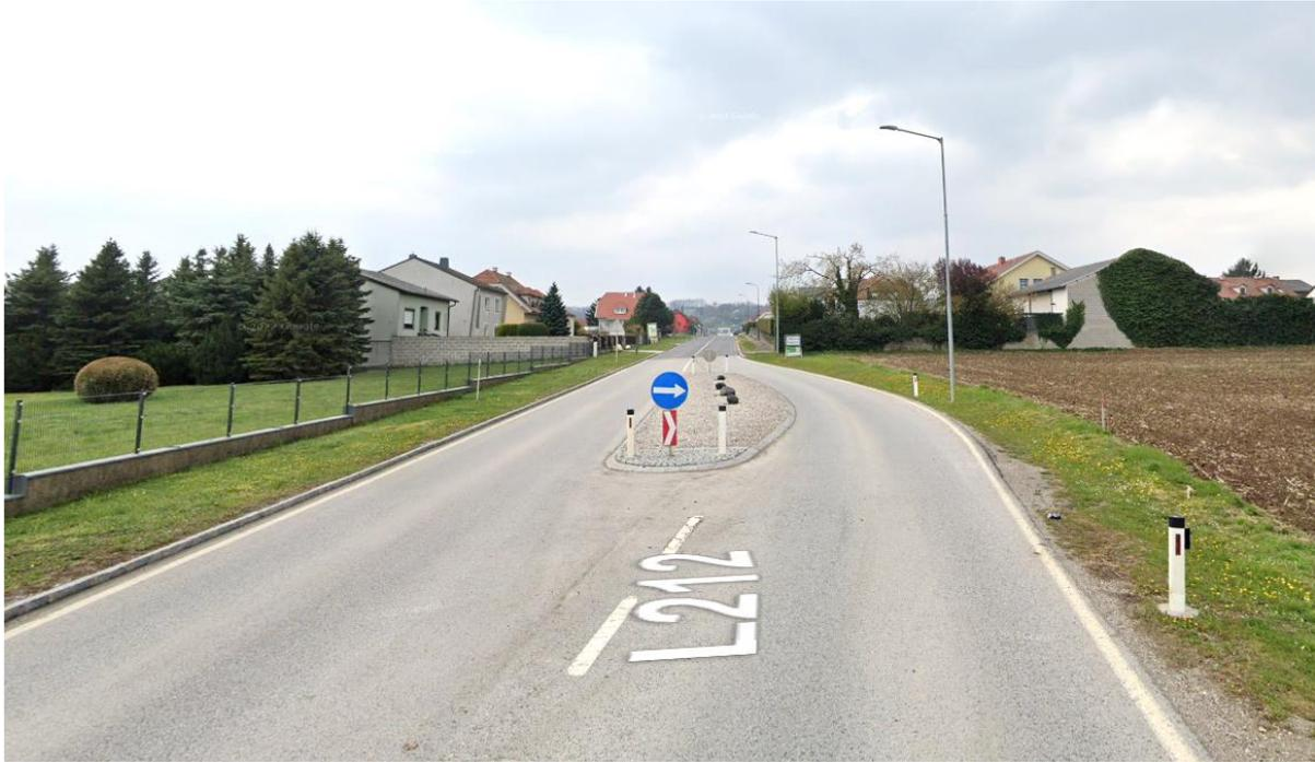
Abbildung 32: Good Practice-Beispiel für einen Fahrbahnverschwenkung mit ausreichender Versatztiefe <sup>40</sup>
