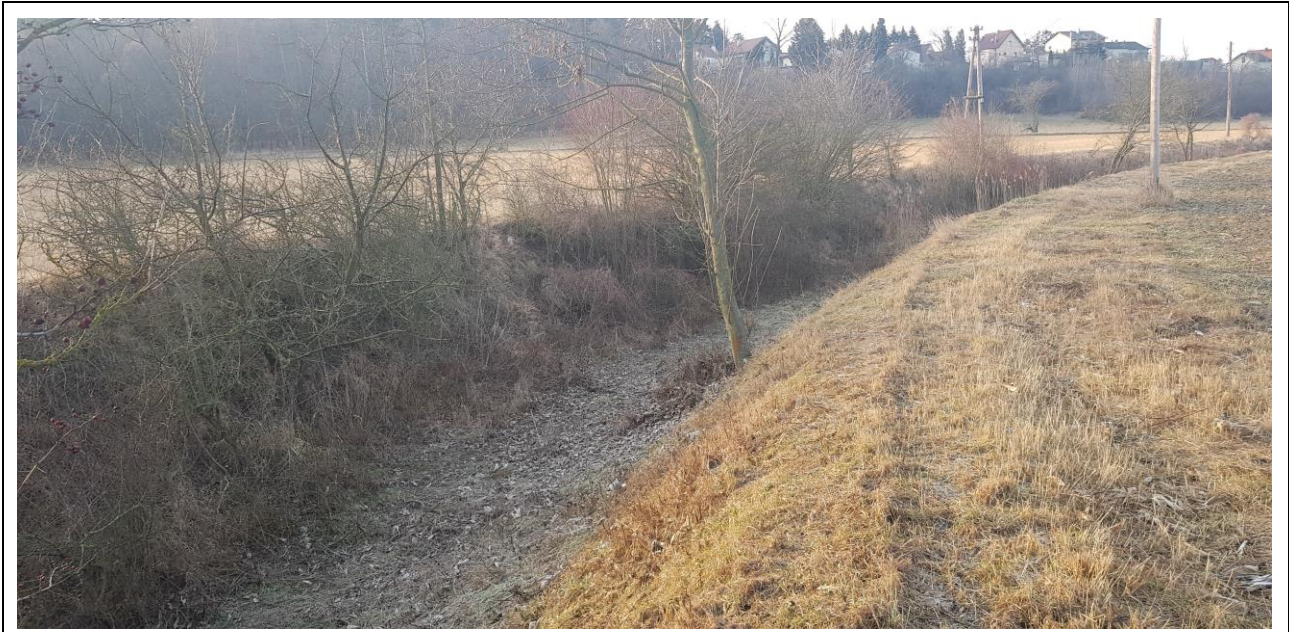
Abb. 9: Seebrückengraben unterhalb des Durchlasses (Gabriel, 20.02.2019)
