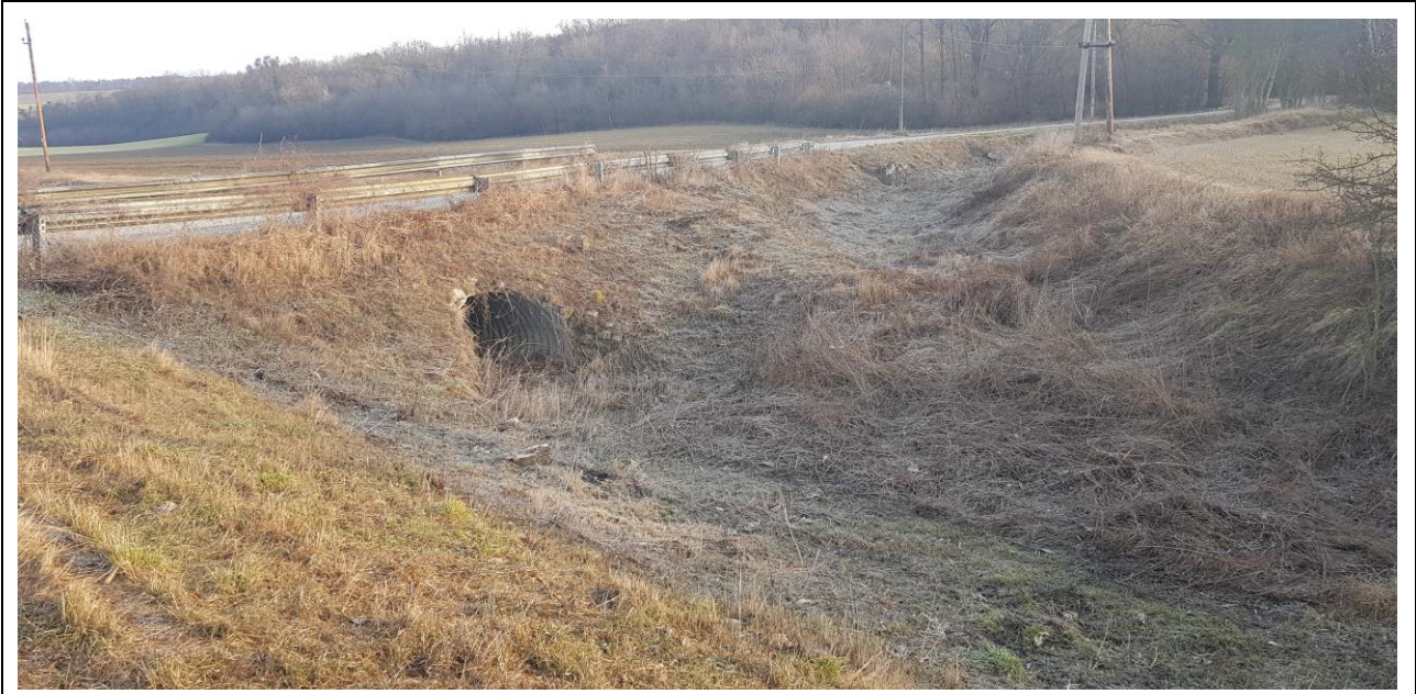
Abb. 10: Durchlass unter der Zufahrt zur Schießstätte (Gabriel, 20.02.2019)
